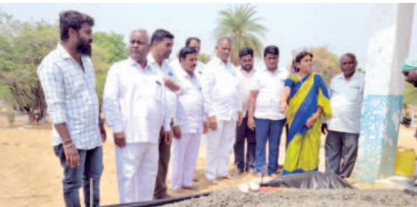
సీసీ రోడ్డు పనులను ప్రారంభిస్తున్న సర్పంచి భాగ్యమ్మ అంజనేయులు
